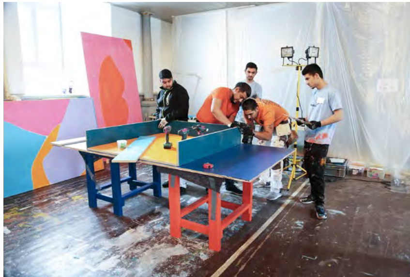
Medsnekkere i prosjektet var Giovanni, Emram, Kalle, Cerfin, Leonardo, Serafin og Kevin. Noen hadde relevant arbeidserfaring fra før av, mens andre hadde aldri tatt i en drill eller en pensel.
